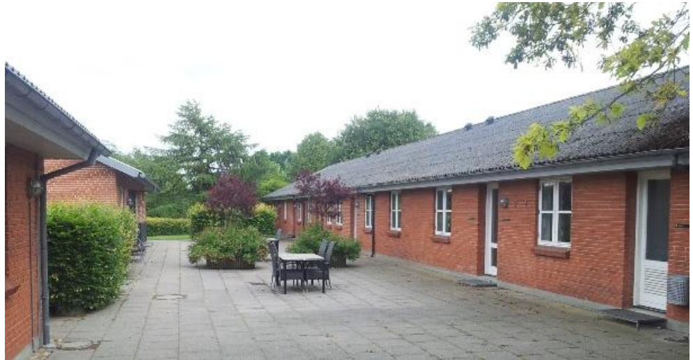
Elevfløje set fra vest ved kantinebygningen.
