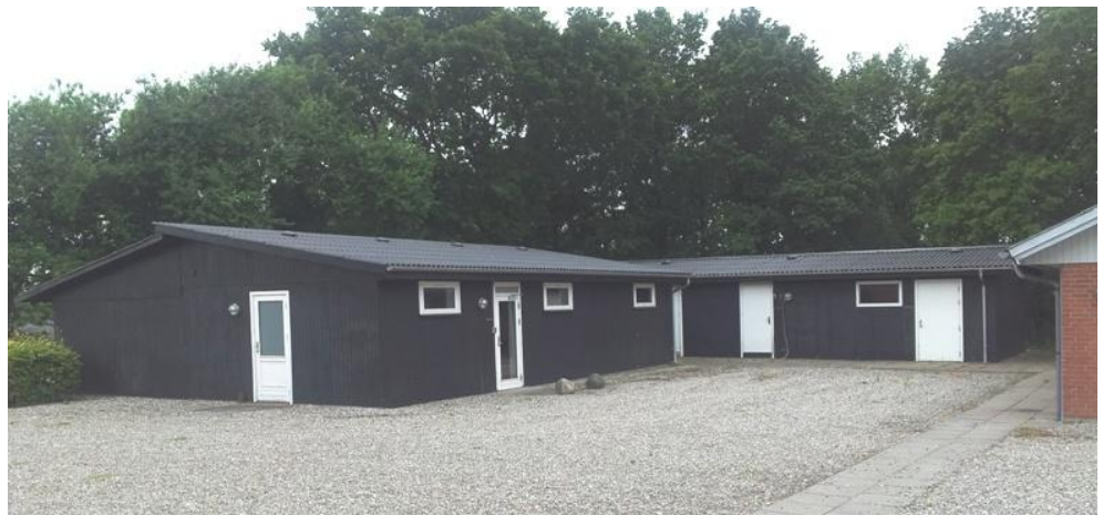
I bygningen til venstre har været lager og motionsrum. I bygningen bagved til højre har været frilufts- og cykelværksted, set fra nordøst.
